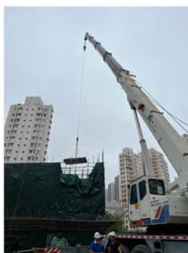
吊運已切割構件
