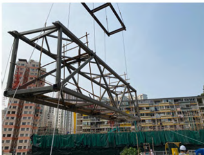
鋼結構框架構件吊運拆卸
