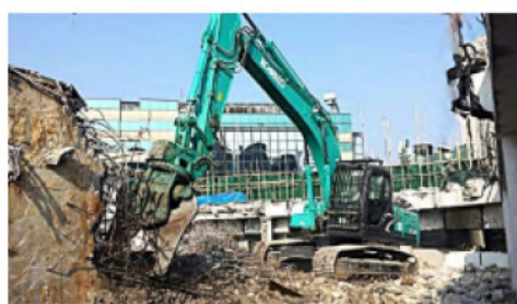
利用附有油壓式破碎配件的挖土機 拆卸鋼筋混凝土牆
