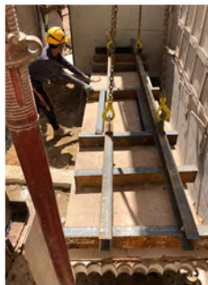
吊運具保育價值的混凝土構件
