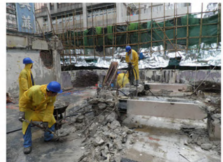
鋼筋混凝土框架拆卸
