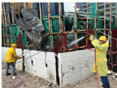
鋼筋混凝土牆分段拆卸
