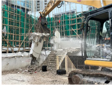
利用液壓粉碎鉗拆除鋼筋混凝土柱
