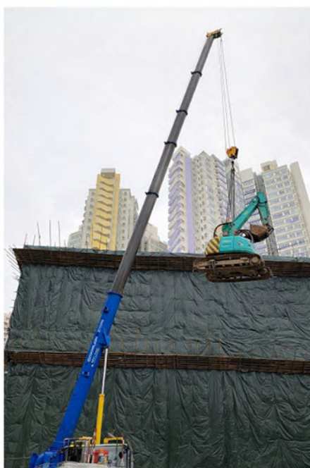
將拆卸機器吊運到樓面
